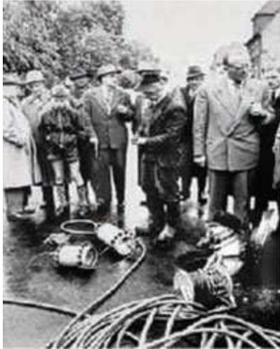
La qualità delle immagine era già molto buona, ma gli svantaggi erano che non si poteva controllare il corretto funzionamento dell'attrezzatura inoltre le immagini e i dati erano disponibili a posteriori, dopo lo sviluppo della pellicola, non durante l'ispezione indiretta.
